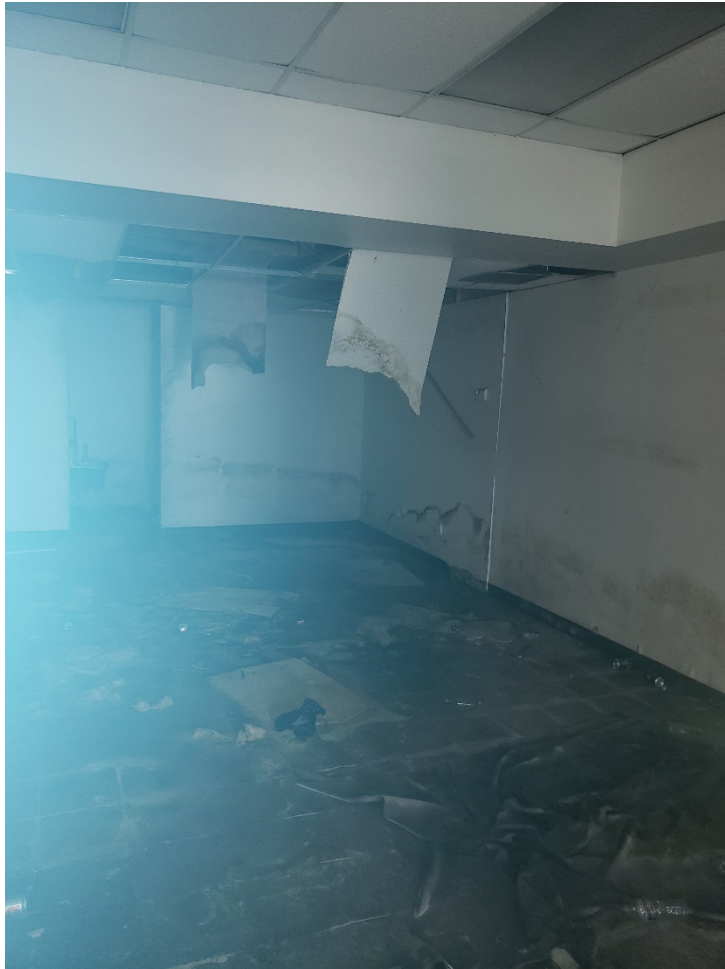
Interior, 2337 Penn Ave, SE
