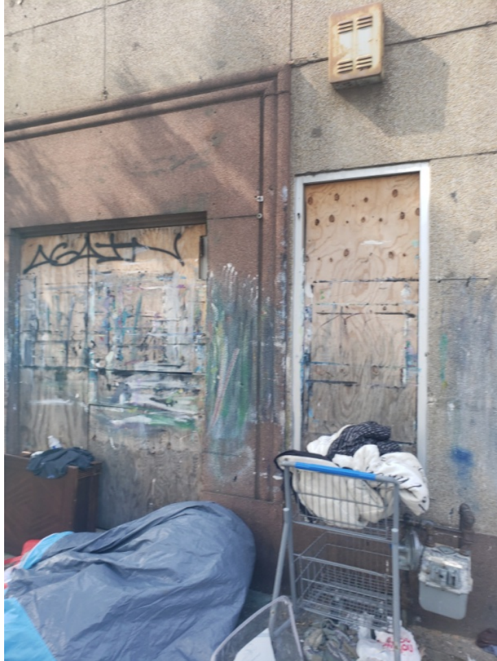
Exterior Front Facade, 2337 Penn Ave, SE
