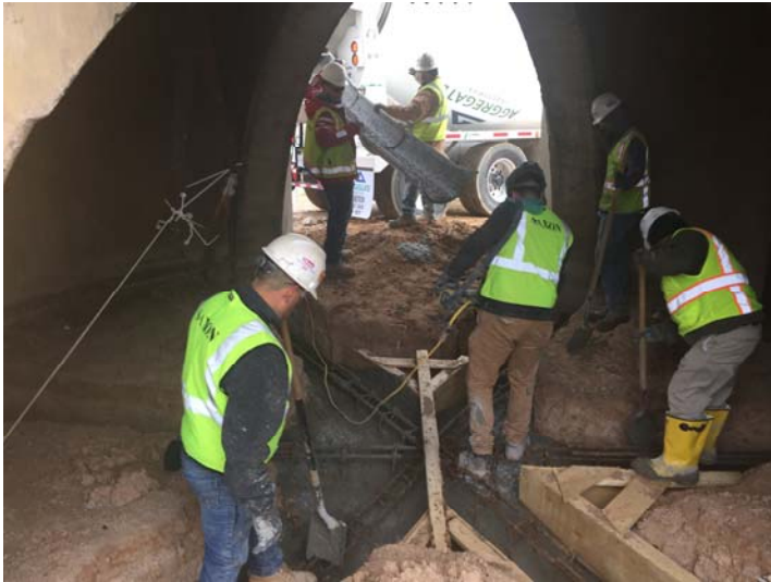
Grade Beam Pour at Sand Bin
