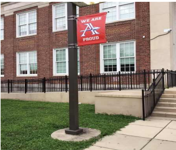
G4022 Poles:- Site Light Pole
