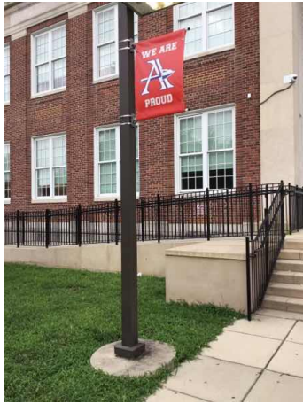
Site Light Pole
