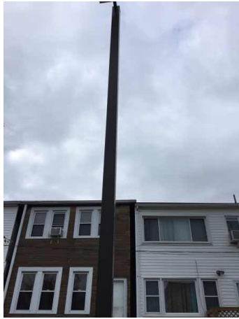
Site Light Pole
