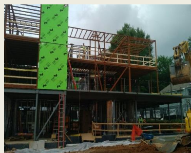
Module Erection
