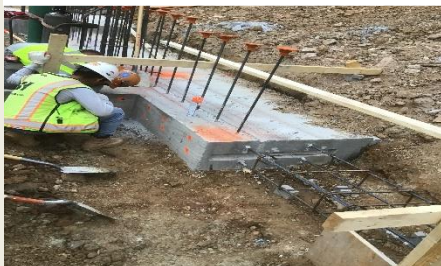
Last Footing Prep For Pour
