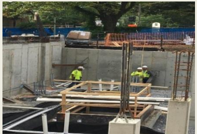
Form and Pour Walls and Columns
